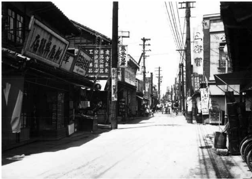
昭和 12 年、早稲田通り。新井薬師道附近より西方を望む。 提供：東京都土木技術支援・人材育成センター
