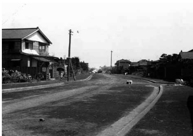
昭和16年、補助34号線工事中。中野区多田町。 提供：東京都土木技術支援・人材育成センター
