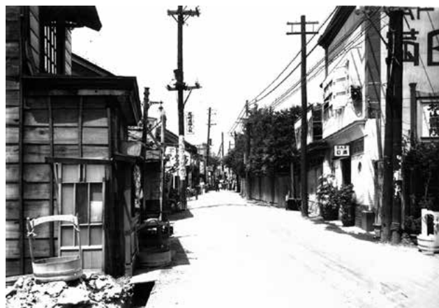
昭和 12 年、補助線 43 号旧景。中野区昭和通三丁目より西方を望む。 提供：東京都土木技術支援・人材育成センター
