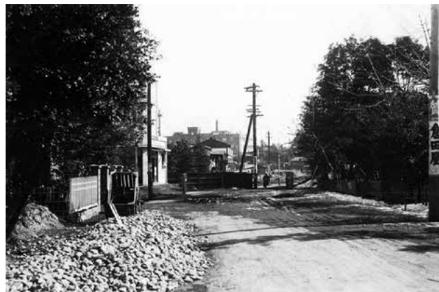
昭和 11 年、中野区宮園町付近。工事前。 提供：東京都土木技術支援・人材育成センター
