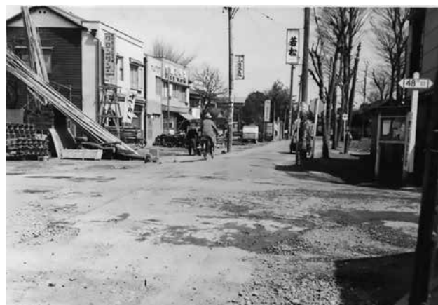
昭和33年12月、江古田4丁目・丸山交差点から東方を望む。道路改修工事。
