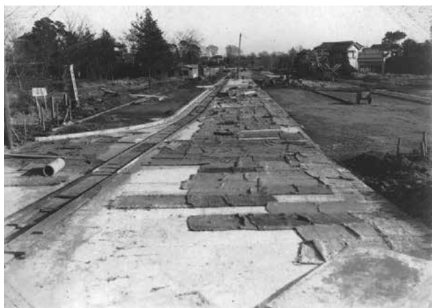
昭和 12 年、放射 7 号線工事中。江古田付近。 提供：東京都土木技術支援・人材育成センター
