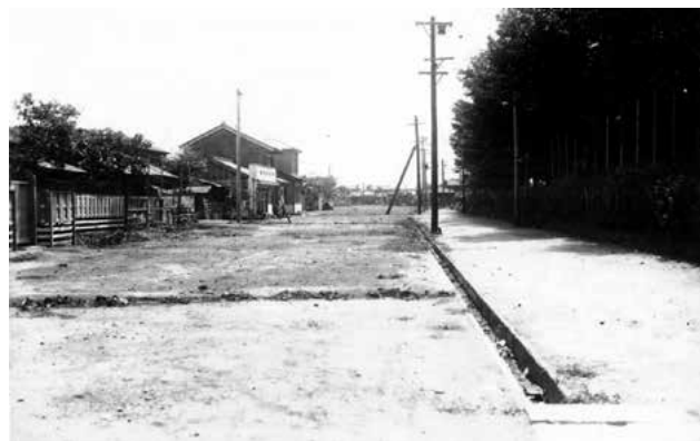
昭和 15 年、補助 34 号線工事前の中野区多田町。東京高等学校西側より東方を望む。
