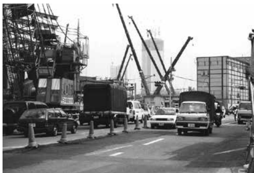
平成 7 年 6 月、山手通りの高速通り地下化工事風景 中央 2 丁目付近。 出典：でじなか ちいきの写真と図書のアークバ
