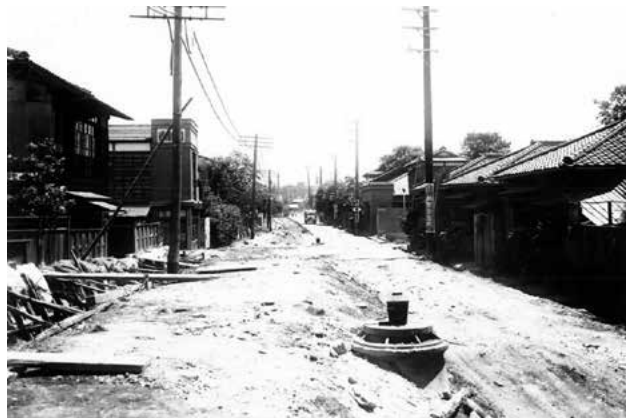
昭和 11 年、宮園通り大正バス道路。工事中。 提供：東京都土木技術支援・人材育成センター
