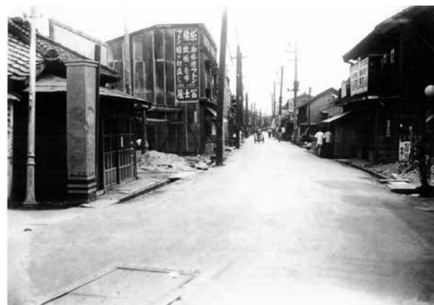
昭和 15 年、早稲田通り工事前。中野区大和町にて東方を望む。 提供：東京都土木技術支援・人材育成センター
