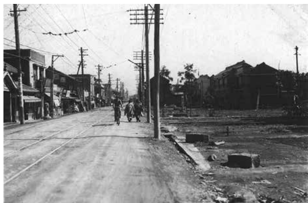
昭和6年、放射6号線沿道の家屋移転中。杉並町中野町界付近より東方を望む。 提供：東京都土木技術支援・人材育成センター
