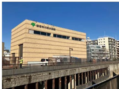
善福寺川取水施設外観。 写真：職員撮影
