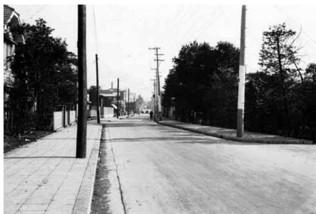
昭和 12 年、末広橋付近。竣工。 提供：東京都土木技術支援・人材育成センター
