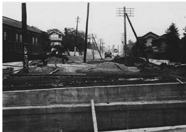
昭和14年、環状6号線工事中。 塔ノ山町(現・中央1丁目、2丁目)付近 提供：東京都土木技術支援・人材育成センター
