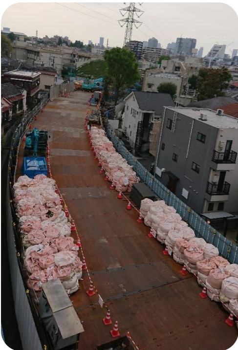
現在の工事現場の様子 野方図書館屋上より撮影
