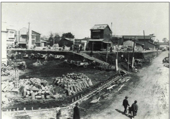
昭和3年 中野駅北口広場拡張工事 (提供：中野区)
